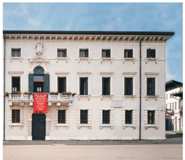
Comune di Sommacampagna (VR): Palazzo Terzi. Intervento di deumidificazione effettuato nel 1985. Barriera idrofobizzante: DryKit System. Formulato: TRE 128 + TRF 135 nelle superfici affrescate
