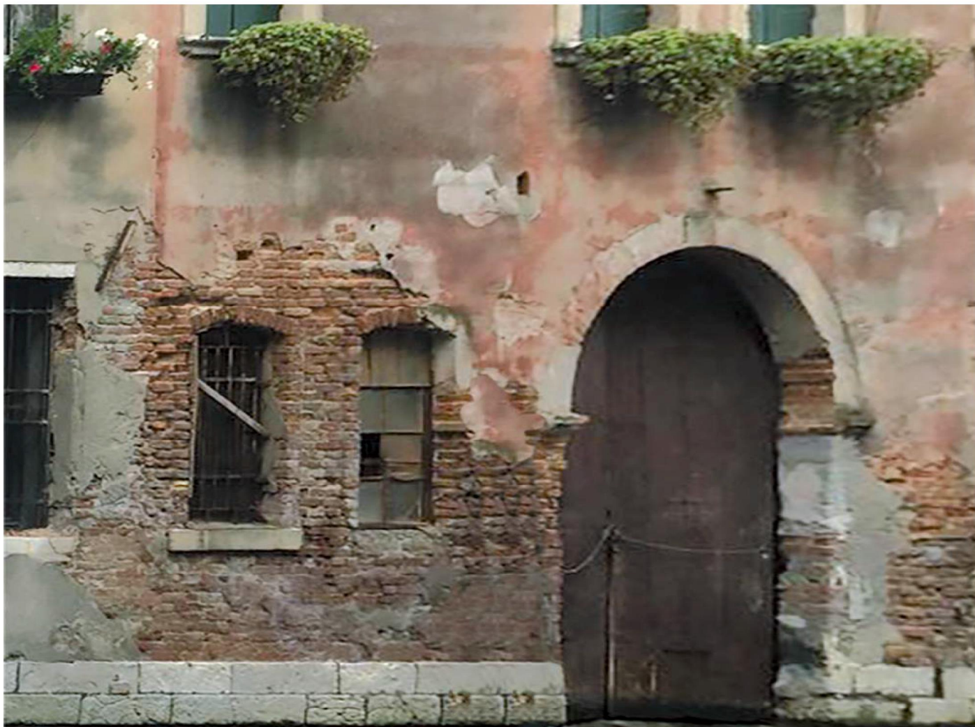
LE BOIACCHE ANTISALINE IMPEDISCONO L'IDRATAZIONE DEI SALI DURANTE LA FASE DI ASCIUGATURA DEL NUOVO INTONACO PROTEGGENDOLO NEL TEMPO
