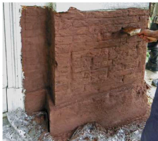
LE BOIACCHE ANTISALINE IMPEDISCONO L'IDRATAZIONE DEI SALI DURANTE LA FASE DI ASCIUGATURA DEL NUOVO INTONACO PROTEGGENDOLO NEL TEMPO
